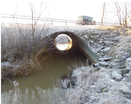
Kulvert under E18
