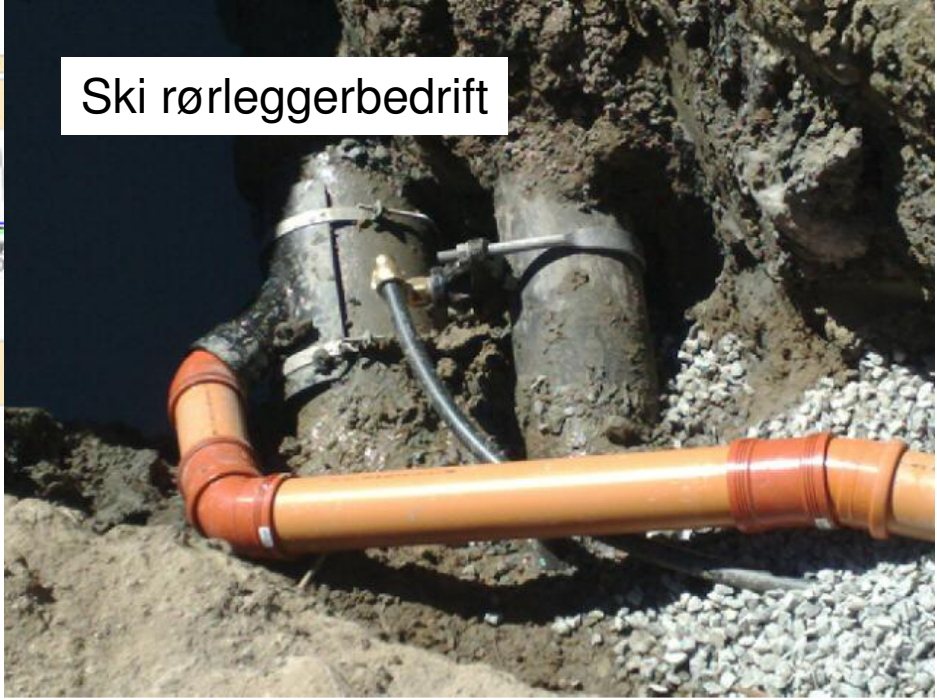
Figur 3: Tilkobling av sadelgren på betongrør.
