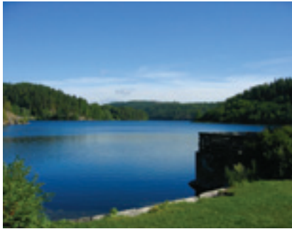
Gjersjøen sør mot vannverk Foto: Oppegård kommune
