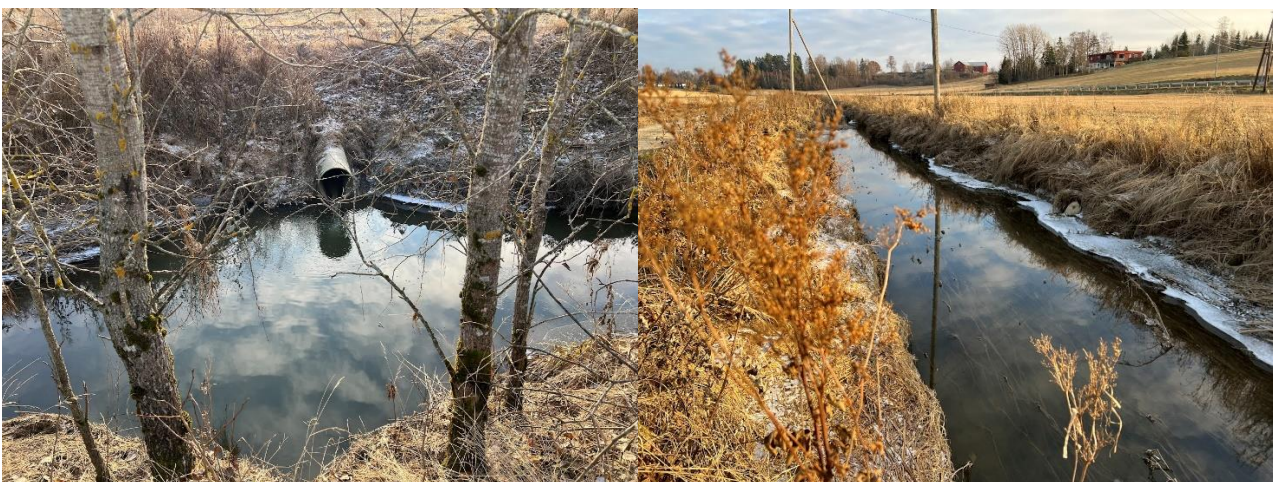
Figur 11. Venstre (13): Utløp fra drenerør, og høyre (14): Bekkeløpet
