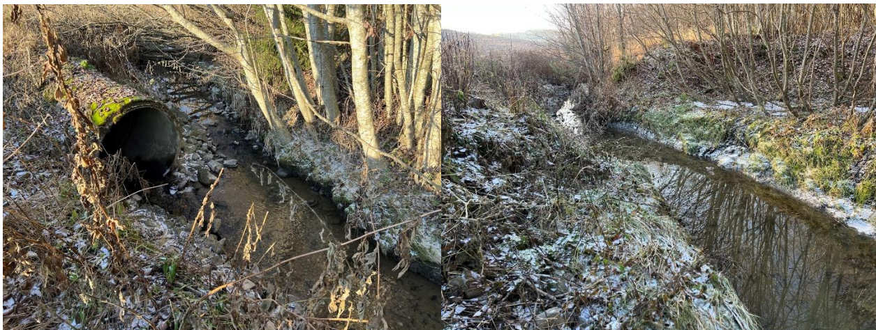
Figur 4. Venstre (1): utløp av rør (drenasje fra jordene?), og høyre (2): bekkeløpet nedstrøms.
