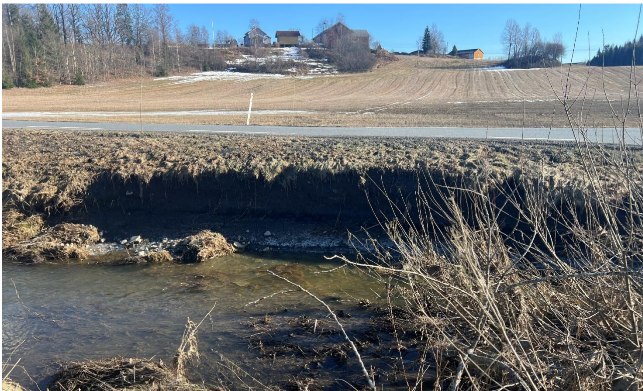
Figur 2. Eksempel på utrasing av bekkekanten forårsaket av erosjon (foto: Norconsult).
