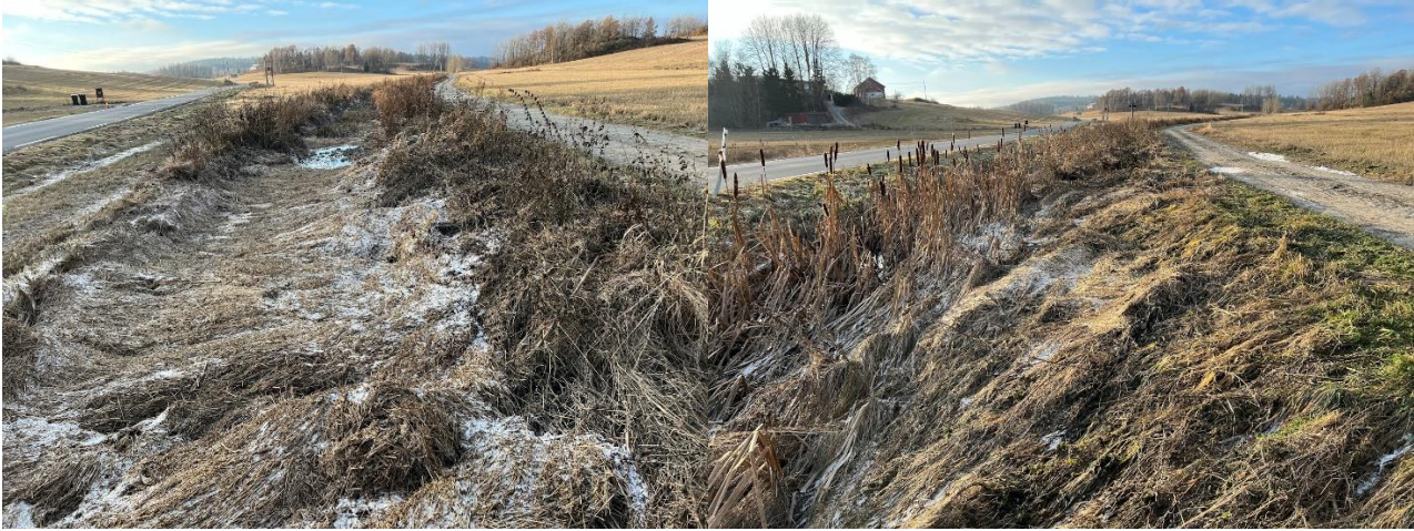
Figur 13. Venstre (15): Strekningen oppstrøms Bakker bru, med tegn til oversvømmelse, og høyre (16): mye vegetasjon i bekkeløpet.
