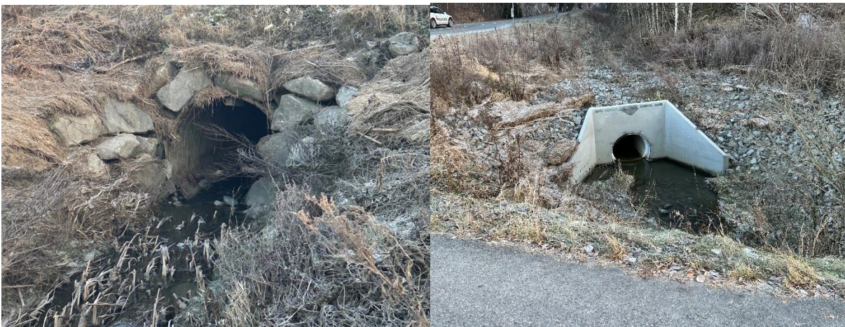
Figur 19. Venstre (26) Kulvert under Sørbråtenveien sett nedstrøms. Høyre (27) Kulvert som fører bekken langs Osloveien sett nedstrøms.
