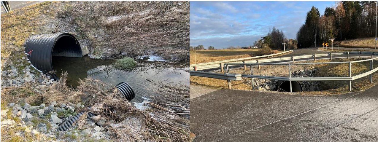
Figur 14. Venstre (17): Innløp til kulvert under krysset ved Bakker bru, og høyre (18): kulvert (del 2) under Bakker bru.
