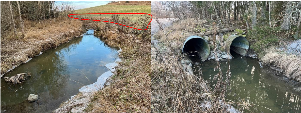
Figur 16. Venstre (21) bekken har gravd seg ut ved østlig bredd. Høyre (22): Kulverter sett nedstrøms
