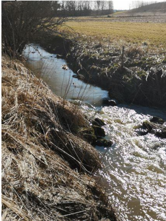
#11 Eksisterende terskel som ikke er erosjonssikker
