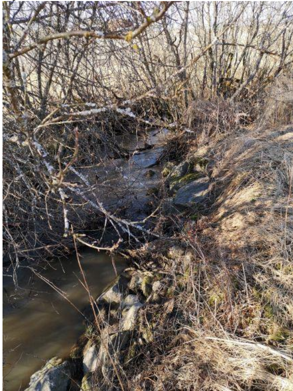
#11 Eksisterende terskel som ikke er erosjonssikker
