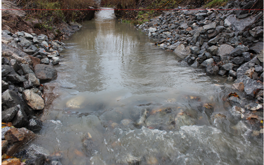
Etablering av kunstige terskler i bekken bremser farten på vannet og gir mindre erosjon.
