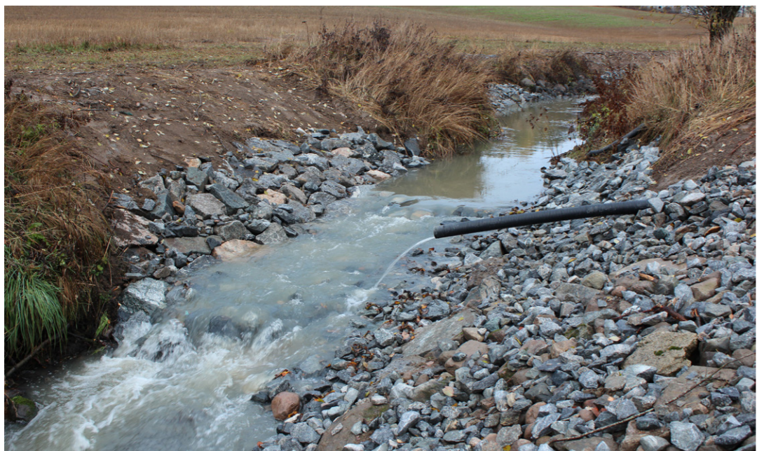
Der det er litt brattere er det etablert to terskler med kort mellomrom. Dette sikrer nedbremsing av vannet og reduserer erosjonen i disse ekstra utsatte områdene.
