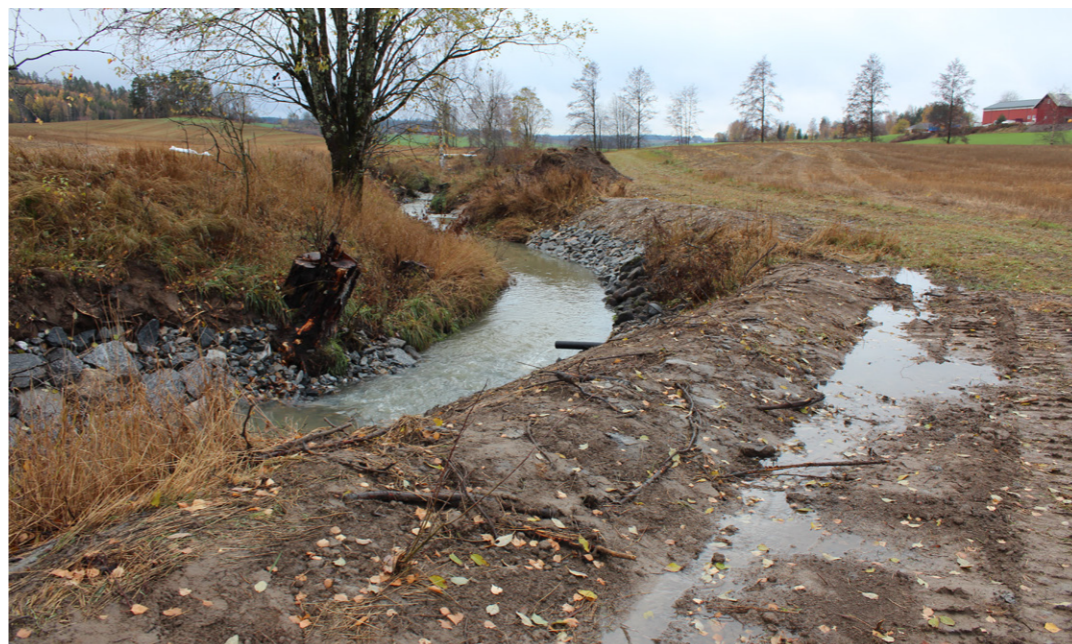
Enkelte steder heller jordet ned mot bekken og fare for avrenning med erosjon er ekstra stor. Her er det etablert lave jordvoller som hindrer vannet i å renne direkte ut i bekken.
