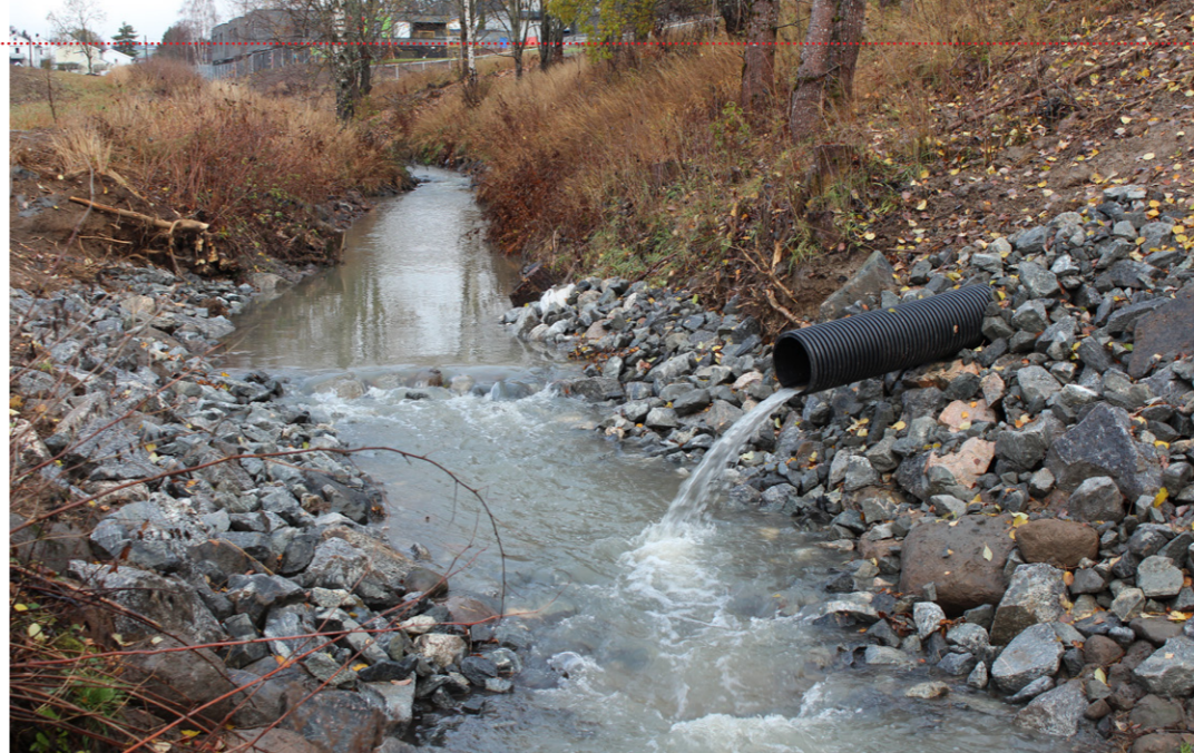
Drensledninger er oppgraderte og erosjons-sikring rundt utløp er utført ved plastring med fiberduk og stein. Dette hindrer erosjon rundt rørutløpene.
