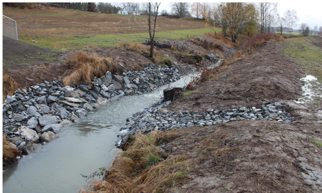
Mellom de lave jordvollene er det etablert en trasé for vannet slik at det når bekken på en kontrollert måte. Traséen er steinsatt.
