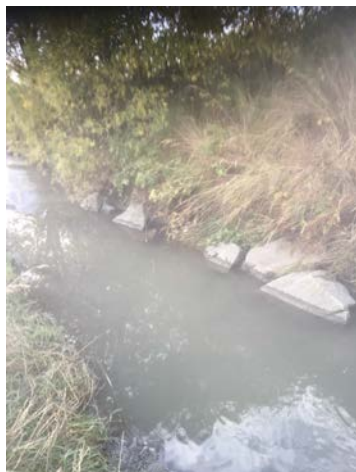
Reparasjon av steinsetting
