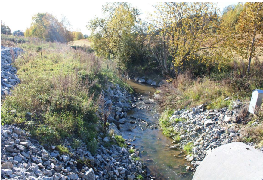
Bilde 4 Finstadbekken ved Eikeliveien. Erosjonssikring med kult/ sprengstein Foto: Lars Martin Julseth
