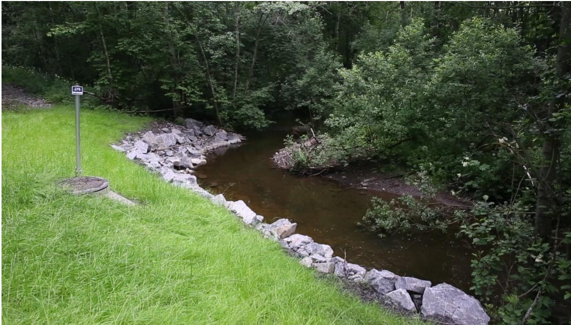
Bilde 17 Eksempel på steinsetting av bekkekant Foto: Sweco
