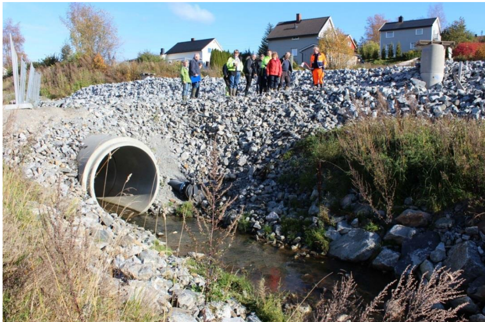
Bilde 3 Utløp kulvert ved Eikeliveien. Bilde fra befaringen Foto: Lars Martin Julseth
