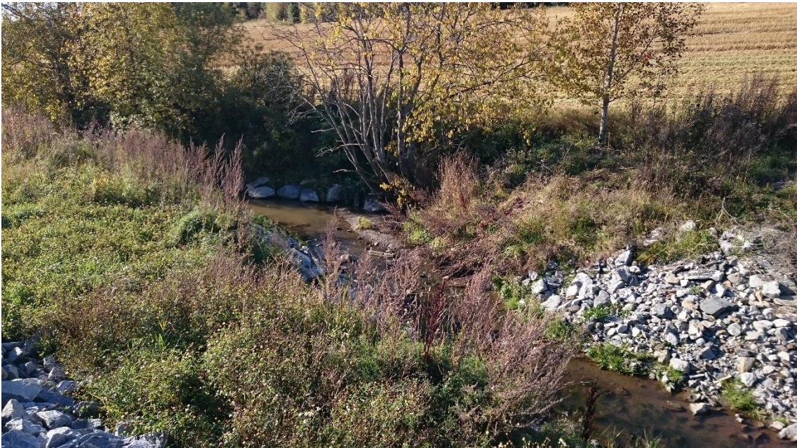
Bilde 16 Finstadbekken ved Eikeliveien. Erosjonssikring med stein. Foto: Sweco
