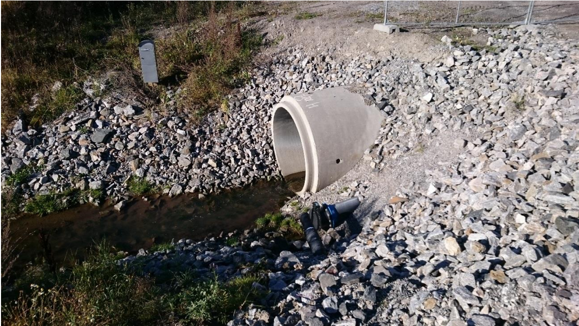
Bilde 15 Utløp overvannskulvert i Eikeliveien Foto: Sweco
