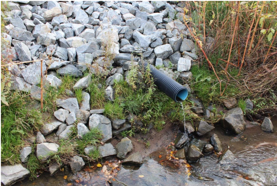
Bilde 11 Erosjonssikret utløp Foto Lars Martin Julseth
