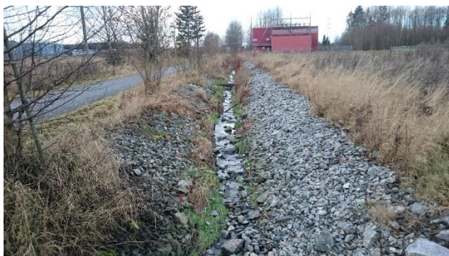
Bilde 1 Finstadbekken åpen og erosjonssikret ved Finstad trafostasjon, vest for jernbanen. Trafostasjonen i bakgrunnen. Foto: Sweco
