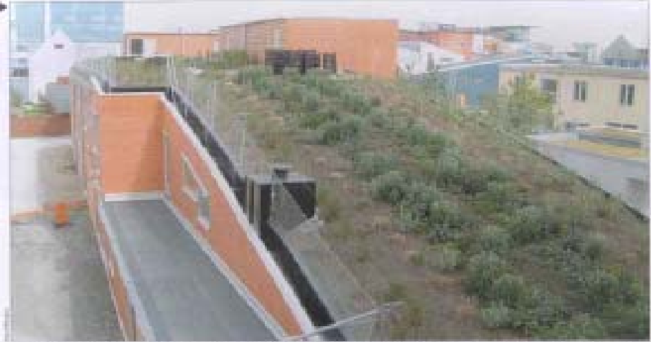
Grønne tak (Sedum) på Bo01 i Oslo. Bildet viser hvordan sedumtak kan bidra til å redusere vannavrenningen og dermed redusere belastningen på vannledningsnettet. Sedumtak er også et godt valg for byggherrene fordi det er et billig og lett å vedlikeholde alternativ.
