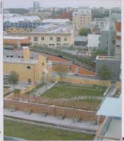
Grønne tak (Sedum) på Bo01 i Oslo. Bildet viser hvordan sedumtak kan bidra til å redusere vannavrenningen og dermed redusere belastningen på vannledningsnettet. Sedumtak er også et godt valg for byggherrene fordi det er et billig og lett å vedlikeholde alternativ.
